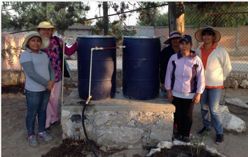
Sistema de tratamiento de bio carbón en la escuela primaria de Vergel de Guadalupe
